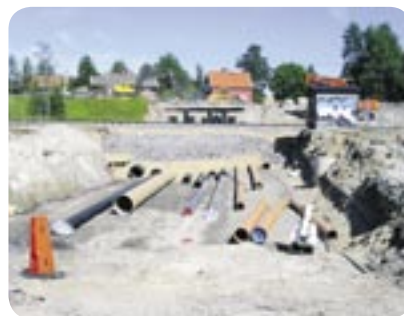
Ledningsomläggningar vid Strömpilen för Botniabanan dragnig.
