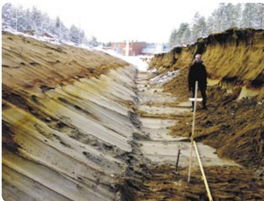
Bygget av den nya sedimentationsdammen vid Fordslunda vattenverk.
